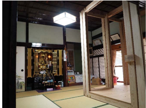
写真 2 U 邸へ開発したシェルターの設置
